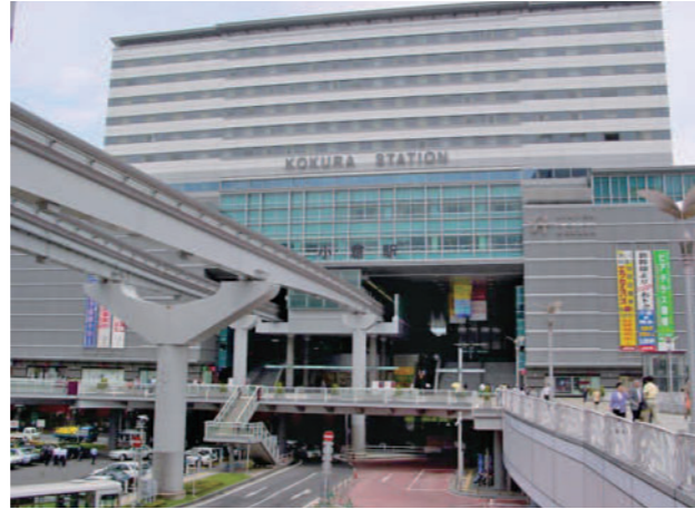
写真2 立体道路制度を活用した小倉駅
