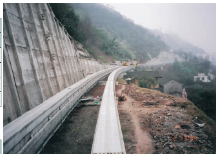
写真3 急峻な地形に建設可能なモノレール路線
