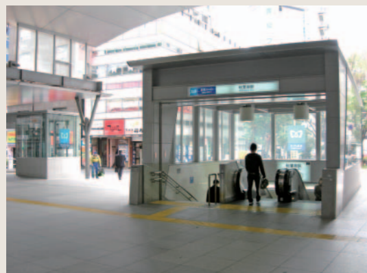
東京メトロ 秋葉原駅エレベーター・エスカレーター
