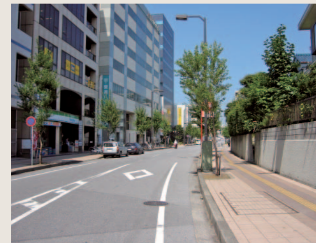
千葉駅北口 電線類地中化
