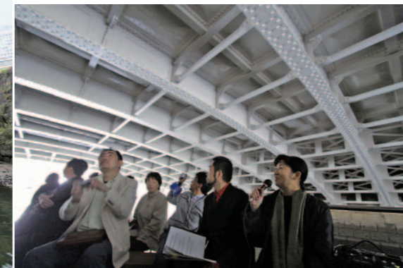
写真6 江戸橋下の空間
