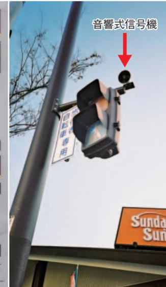
写真3 音響式信号機
