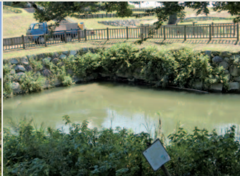
写真7 石井樋の呑み込み口と左側の出鼻
