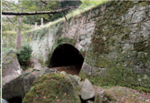
写真9 八勢水路橋の鞘石垣
