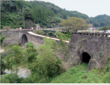
写真10 南側に残る森林鉄道のトンネル
