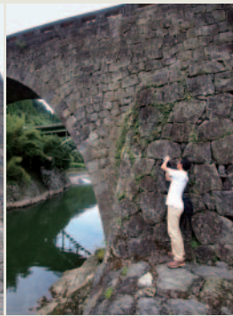
写真5 下流南側の鞘石垣と通石垣
