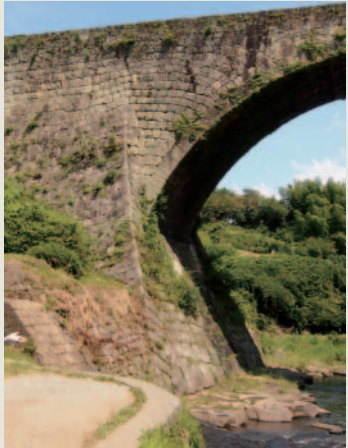
写真7 通潤橋の鞘石垣
