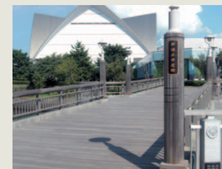
写真2 新波止歩道橋
