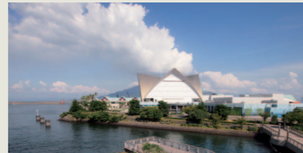
写真1 フェリーターミナルからの旧石積防波堤とかごしま水族館
