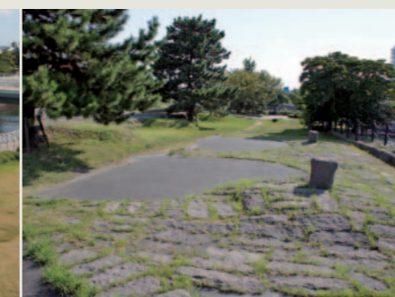
写真5 防波堤天端の形状
