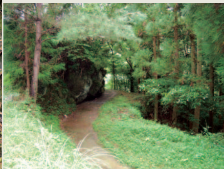
写真4 蓋により流れは見えない七折用水路
