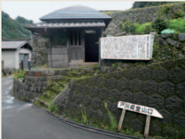
写真5 復元された水車小屋
