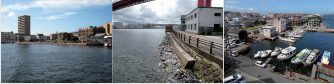
写真4 親水空間として整備された南海岸通り 写真5 浸食防止の工事が施された東海岸通りの石積護岸 写真6 石積護岸が残る若松漁港
