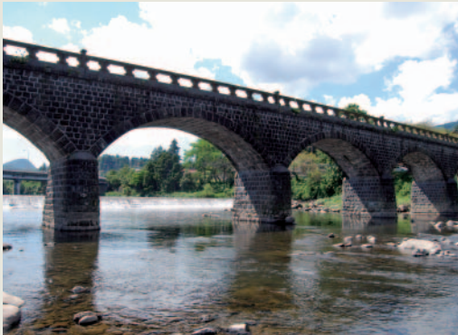
写真7 奥に荒瀬堰と国道212号線が見える右岸下流から見た耶馬溪橋
