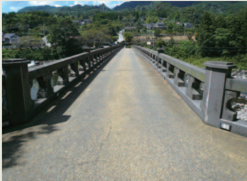
写真5 右岸から望む耶馬溪橋の橋面
