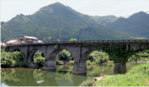
写真10 耶馬溪三橋の一つ「馬溪橋」
