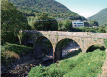
写真8 石橋の貴婦人「鳥居橋」
