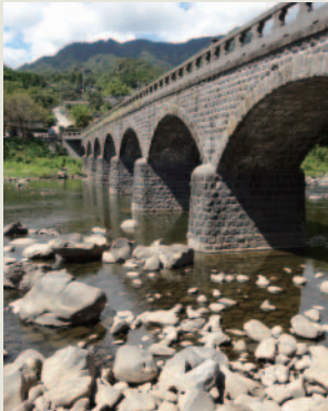
写真6 耶馬溪橋の橋脚とアーチ
