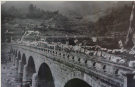
写真2 架橋当時の耶馬溪橋(大正12年3月)
