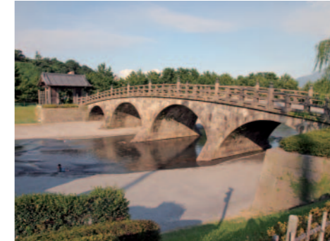
写真7 石橋記念公園に移設された鹿児島甲突川五大石橋西田橋。1846(弘化3)年、石工岩永三五郎等により架橋
