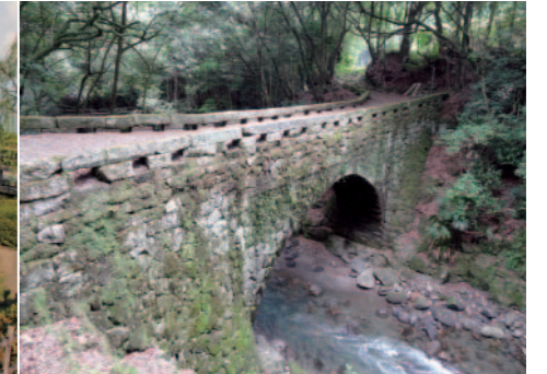
写真8 馬門橋。1827(文政10)年、備前阿津村の小坂勘五郎により架橋
