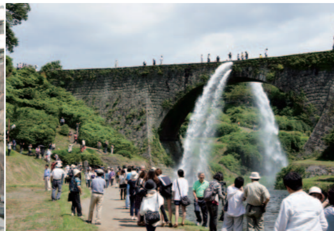
写真6 通潤橋(水路橋)。1854(嘉永7)年、種山石工により架橋
