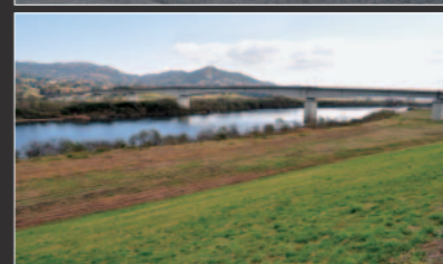
⑥(右) 2001年に完成した5径間連続PC箱桁の高館橋。橋脚には過去の台風時の水位が表示されている ⑦(下) 1934年に完成した木製の初代高館橋。1947年のカスリーン台風により流失した
