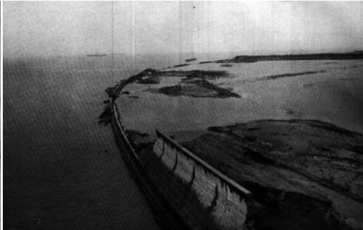
写真1 高潮により破堤した鍋田干拓地の海岸堤防(10月5日)(中部日本新聞社提供)
