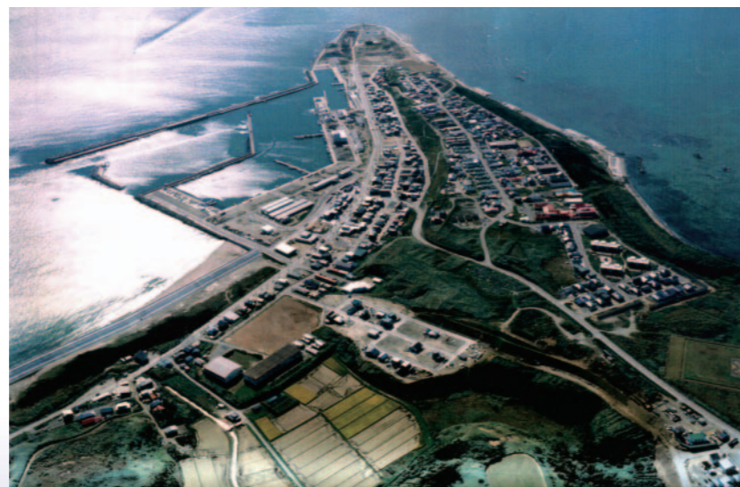
写真3 1996年10月の青苗地区の復興状況(奥尻町提供)
