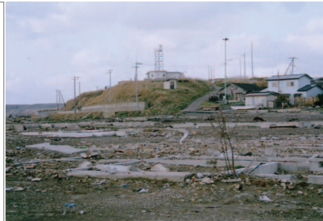
写真2 被災後の岬地区と高台移転候補地
