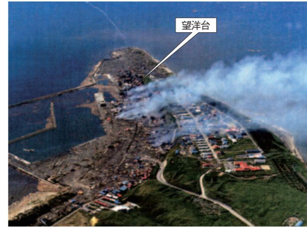
写真1 地震翌朝の青苗地区の被災状況(奥尻町提供)
