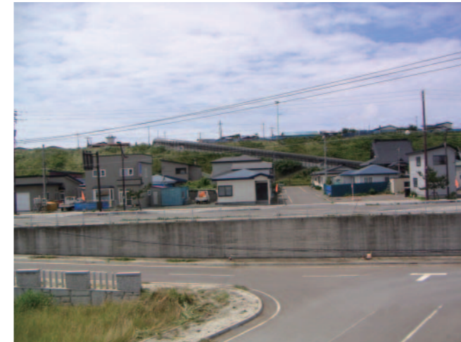
写真4 漁港背後低地部の防潮堤、盛土造成地、高台への避難路
