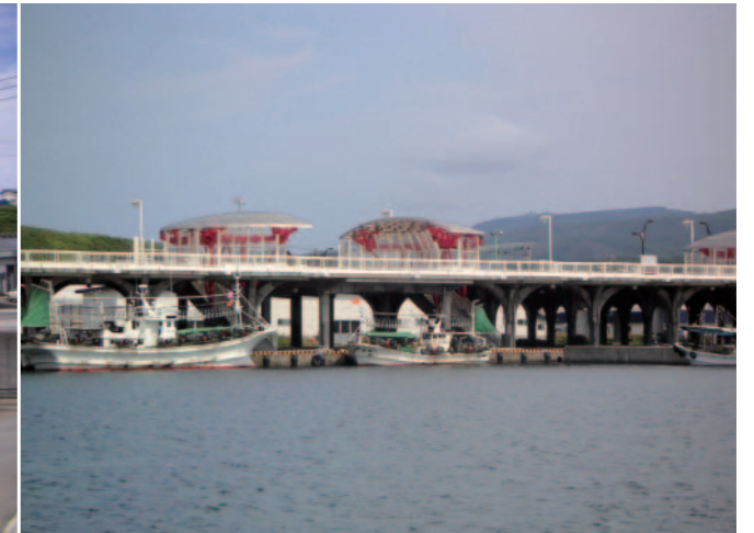
写真5 青苗漁港人工地盤「望海橋」
