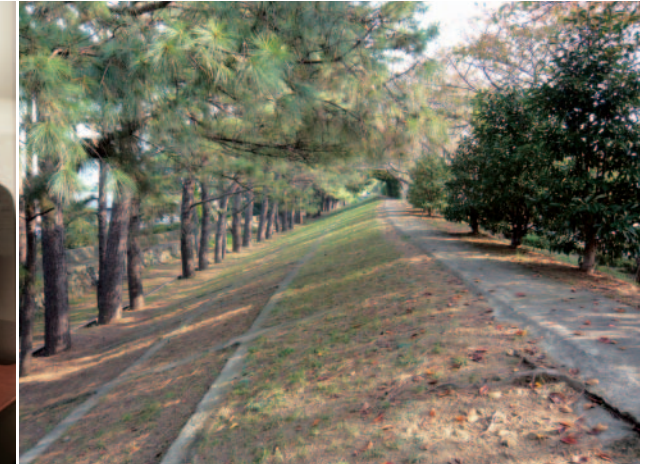
写真2 現在の広村堤防
