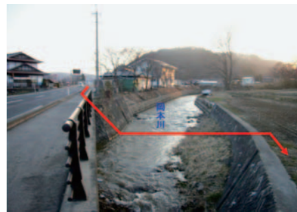
写真11 河川横断箇所
