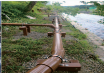
写真7 本管と宅内取付け管の状況
