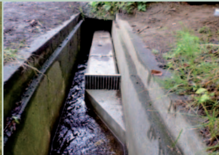
写真10 竣工後の水路
