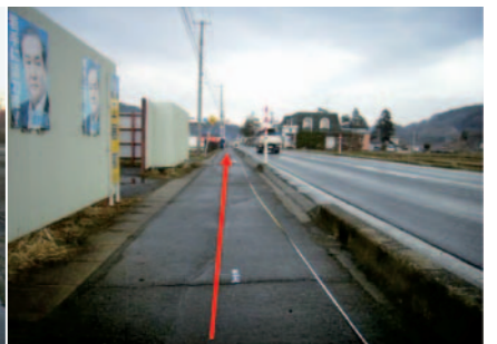
写真12 河川横断後の下水管きよの線形
