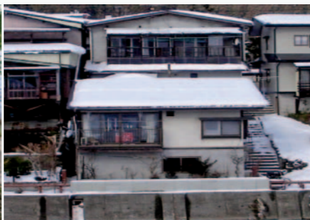
写真8 落雪対策用の管防護コンクリート
