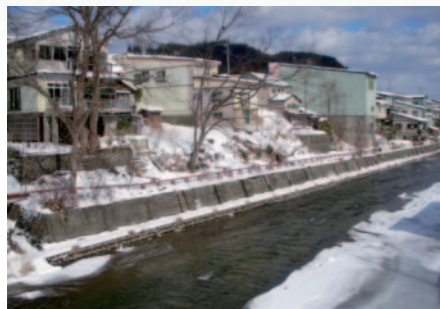
写真6 河川沿いの露出配管全景
