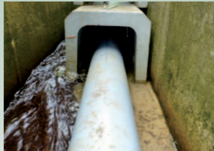
写真9 側溝を活用した下水道管きよ
