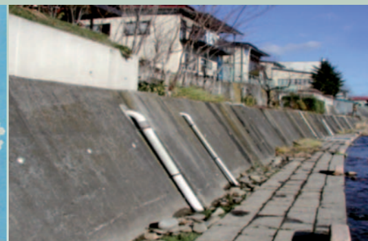
写真1 下水道整備前の安比川左岸
