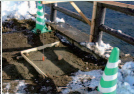
写真5 凍上量測定器設置
