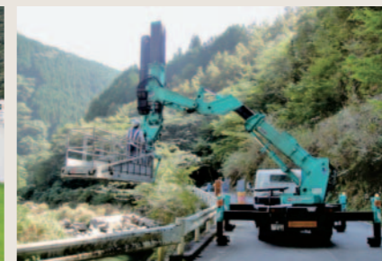
橋梁点検調査(西米良村)
