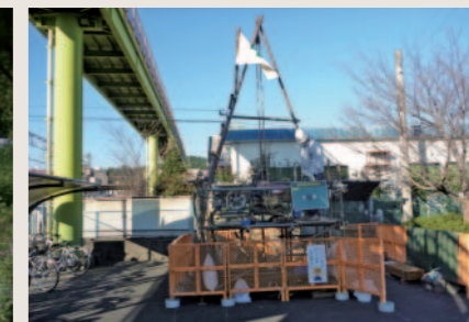
土質ボーリング調査(延岡市)
