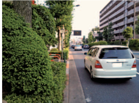
写真13 路肩が狭いと走りにくい
