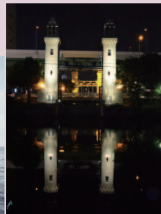
④ 松重閘門
