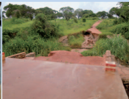
写真5 橋が流されていた道
