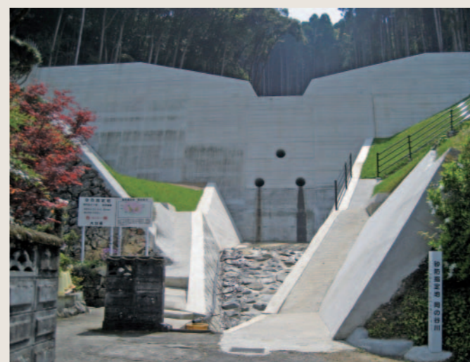
岡の谷川砂防ダム
