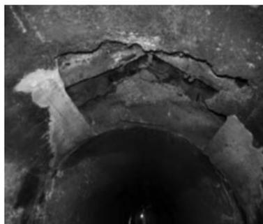
写真1 天端が崩落した水路トンネル
