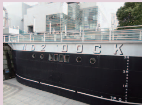
写真6 復元された2号ドックと海を仕切る「船扉」の内側半分
