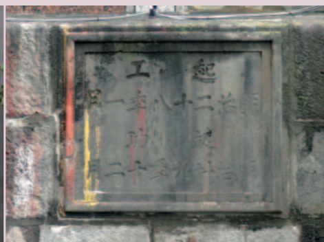
写真8 2号ドックの「起工・竣工」プレート
