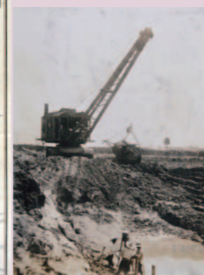
写真2 重機による運河掘削
