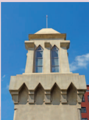
写真8 松重閘門の塔頂部
