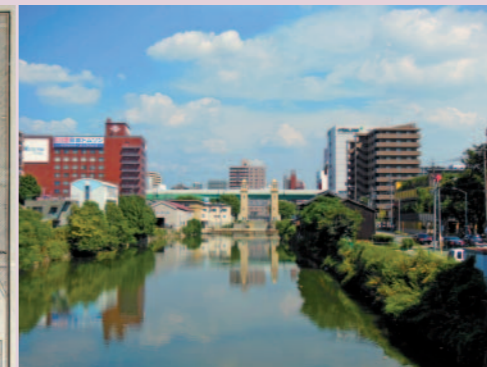
写真1 中川運河東支線と松重閘門
