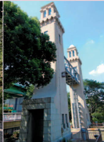
写真10 松重閘門(堀川側)
