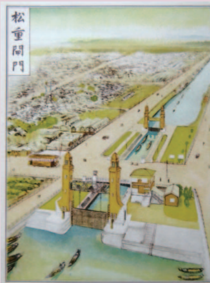
図3 松重閘門鳥瞰図(『名古屋市政の展望図表』より)
