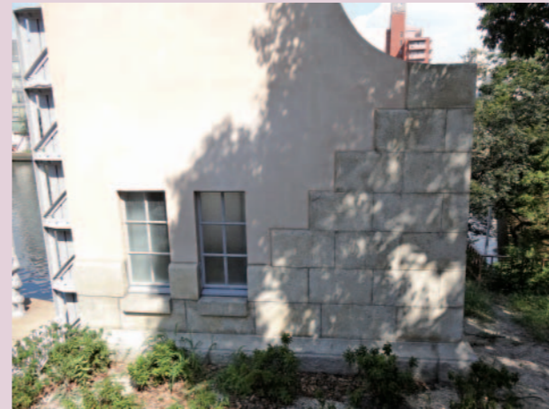
写真9 御影石を階段状に拡幅した塔基部
