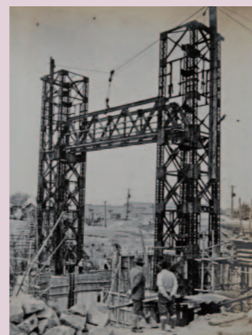
写真3 鉄骨の建方
