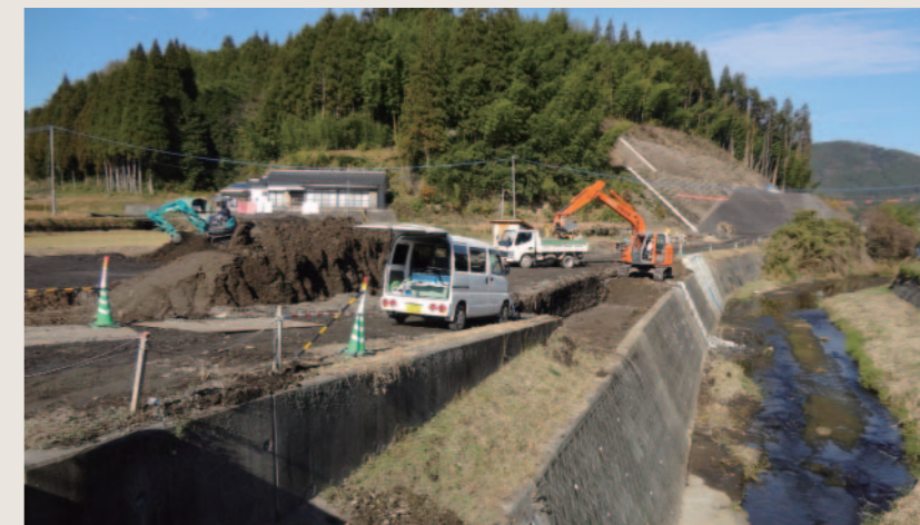
県道玖珠山国線の道路実施設計が終了し、急ピッチで工事が進む様子
