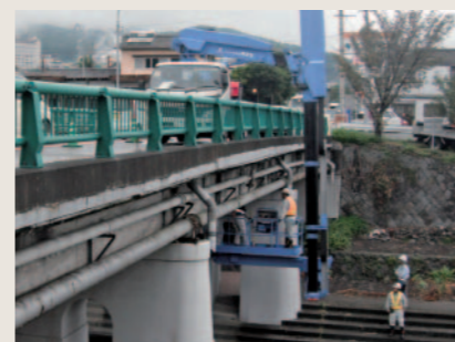
橋梁点検車に乗り込み作業する技術社員
