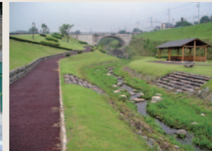
環境に配慮した流路工
