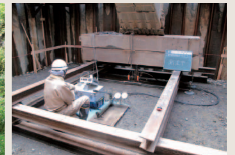
地質調査(平板載荷試験)
