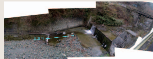
暗渠型の自然石魚道(施工前の施設現況)
