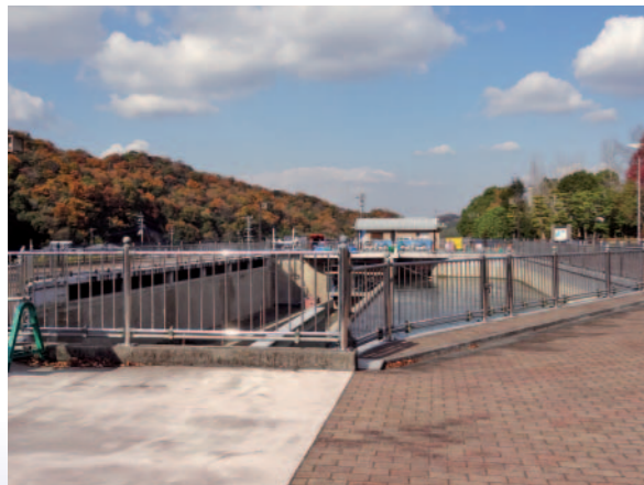
写真4 東西分水工。阿讃トンネルを出た水はここで東西の幹線に分水される
