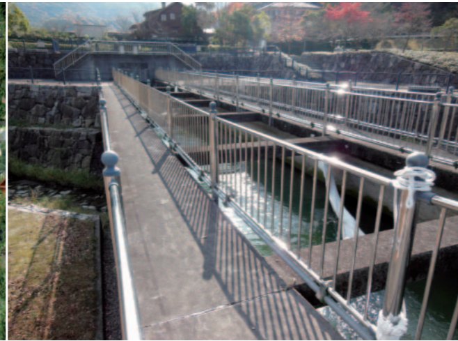
写真3 香川県側の阿讃トンネル出口
