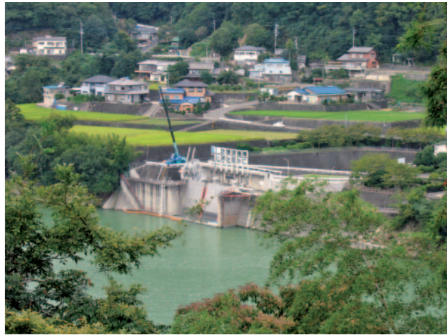
写真2 徳島県側の香川用水取水工。池田ダムで蓄えられた水をここから取り入れる
