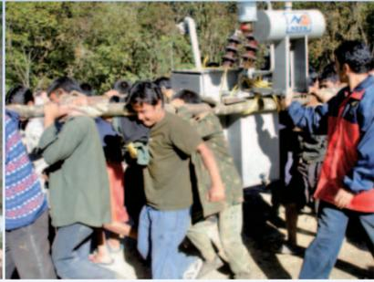
写真9 人力による変圧器運搬
