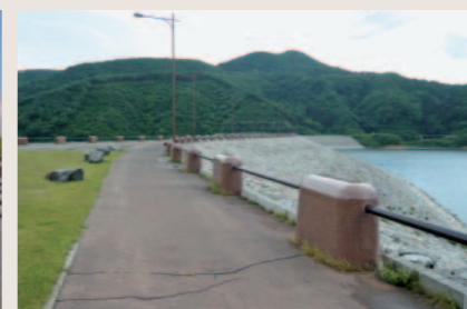
摺上川ダム天端工(高欄、照明灯)
