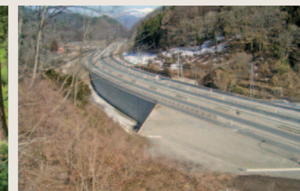
国道改築(4車線道路)と付替河川
