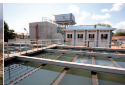
写真2 ジュバ浄水場
