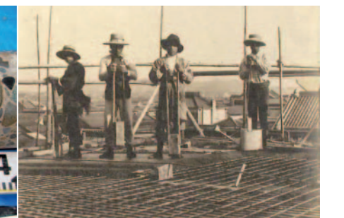
写真5 タコ木を用いた明治時代のコンクリート打設状況
