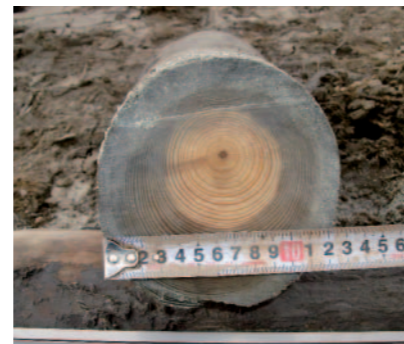
写真3 木杭腐食状況(大正13年施工)
