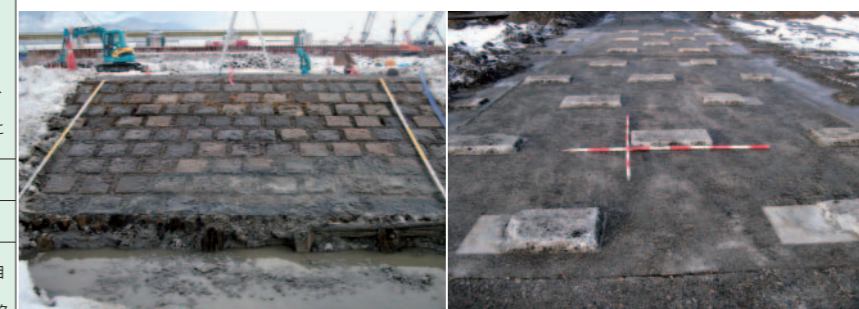
写真2 越流部(左)と水叩き部(右)の表面状況(タイプB)
