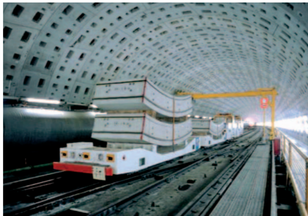
図9 セグメント自動搬送システム(清水建設提供)
