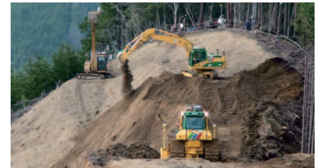
図3 奈良県北股地区での災害復旧対策工事
