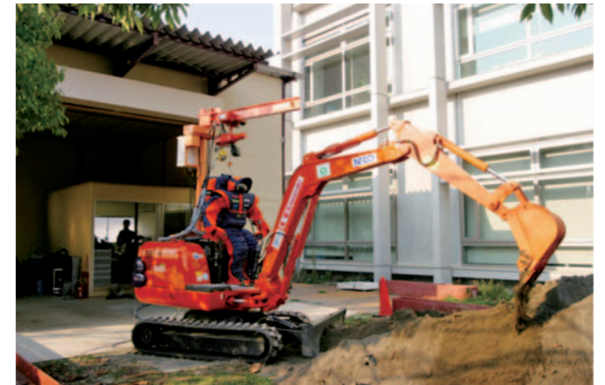
写真1 バックホウを遠隔代行運転するヒューマノイドロボットHRP-1S
