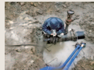
パイプラインの機能診断の状況
