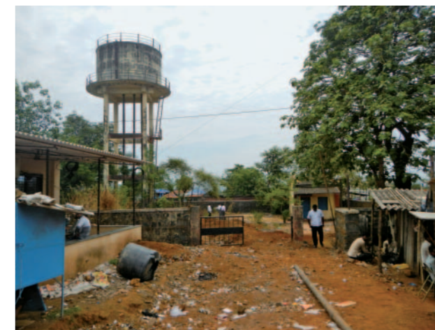
写真2 ゴミが散乱する高架水槽敷地(インドの配水場)
