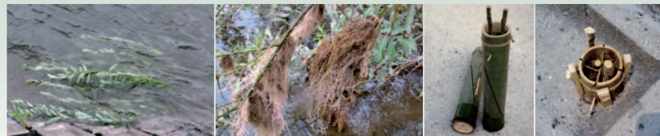
写真6 洪水時の倒伏状況 写真7 枝に発生した水中根 写真8 竹ポット構造体 写真9 竹楔による一次固定
