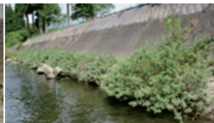
写真11 3年6ヶ月経過時の繁茂状態
