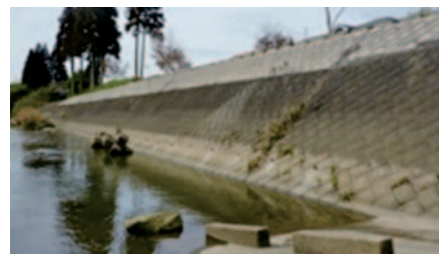
写真10 植栽施工直後の状態
