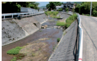
写真1 ブロック積の既設護岸
