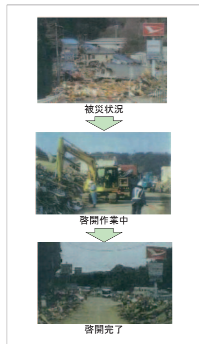
写真1 道路啓開作業の例 1)
