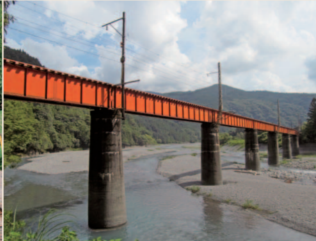
写真4 大井川第三橋梁
