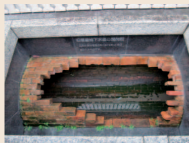
写真7 現在も雨水管として使用されている煉瓦造の下水道
