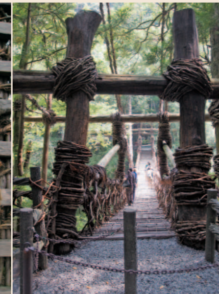
写真2 2本の柱が「とり木」、水平方向が「かさ木」、路面下にある「よこ木」
