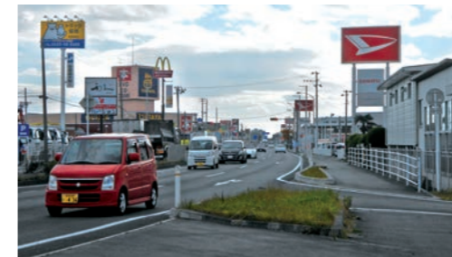
④(下) 現在の岩沼バイパス。1日5万台の交通量を捌く大動脈となっている
