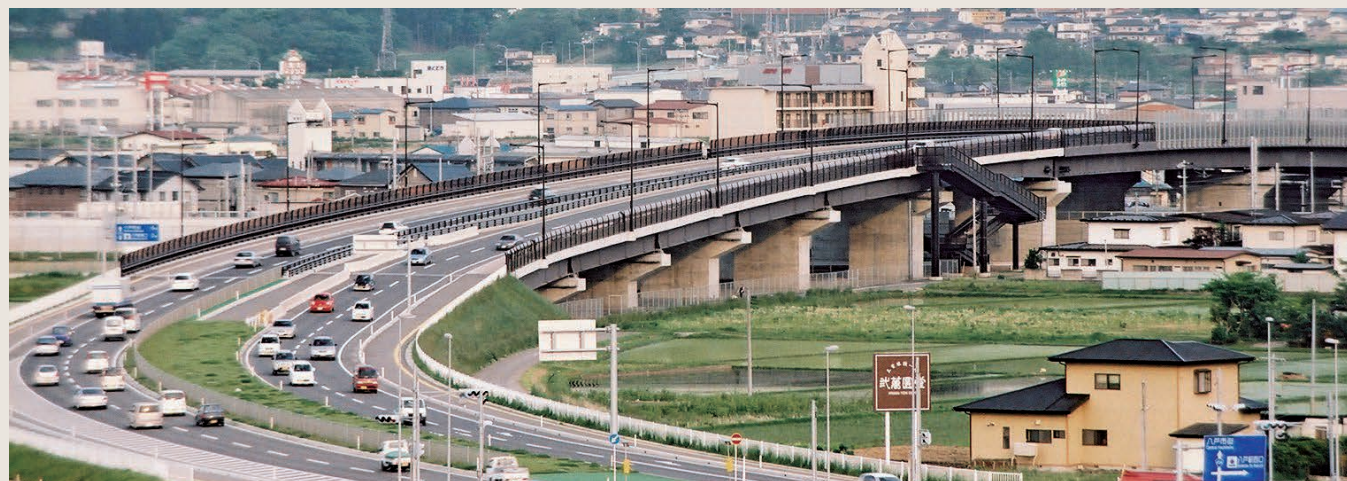
えんぶりっぢ（八戸県土整備事務所）橋長=296m 幅員=12.5m
