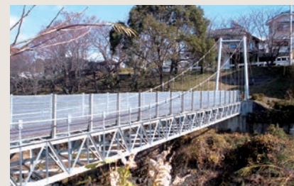
地域を結ぶ橋づくり／鮎壺のかけ橋
