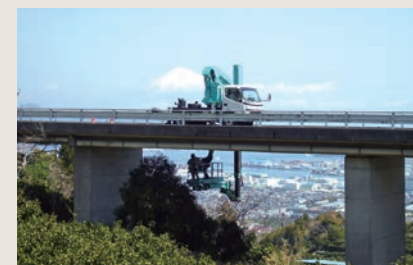
橋梁点検・耐震補強／清水日本平線望岳橋
