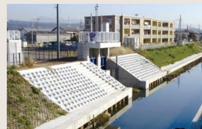
浸水対策／池田川排水機場
