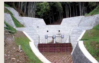
土石流対策／砂防えん堤
