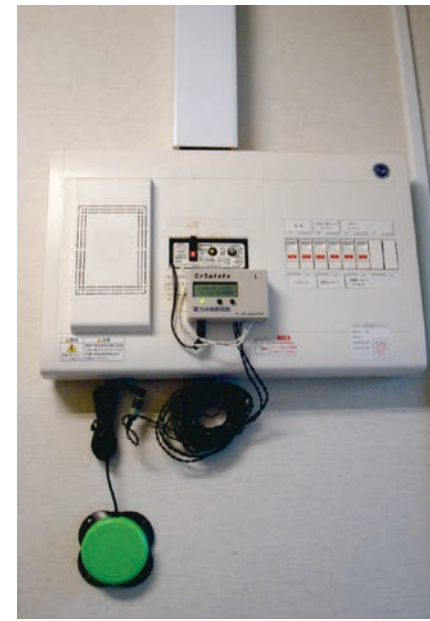
図7 第4次おげんき発信で使用している電力使用による生活行動センサーとおげんき発信一体型
