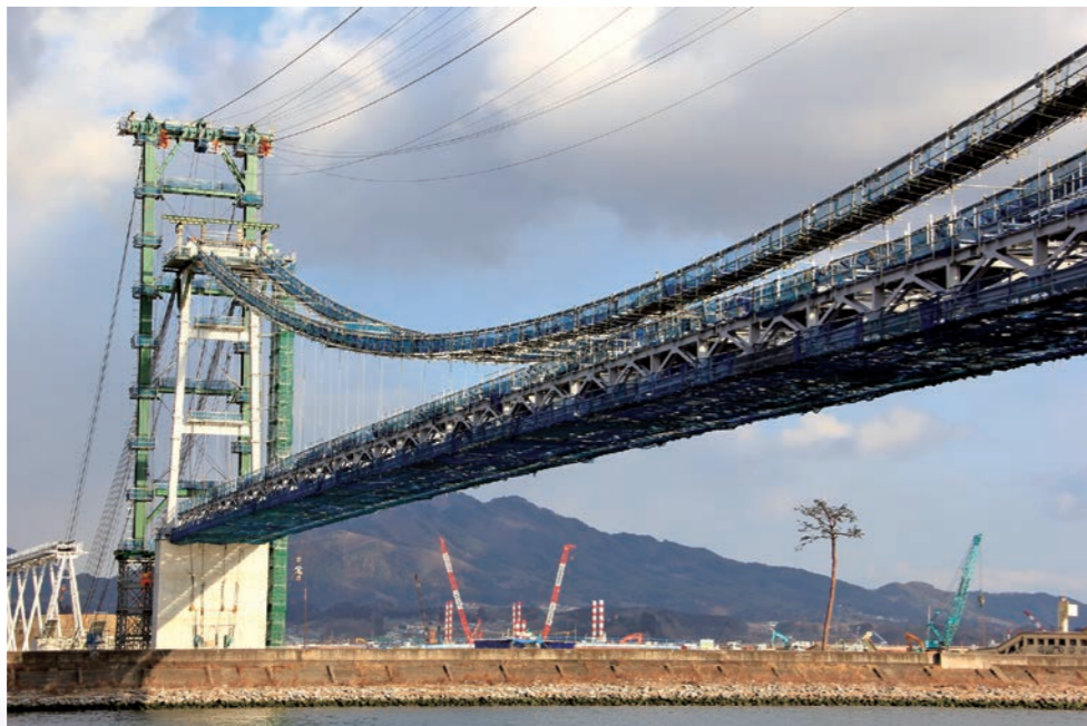
写真1 高台移転造成地からの土砂運搬用のベルトコンベヤー専用つり橋「希望のかけ橋」。遠くに見えるのが奇跡の一本松
