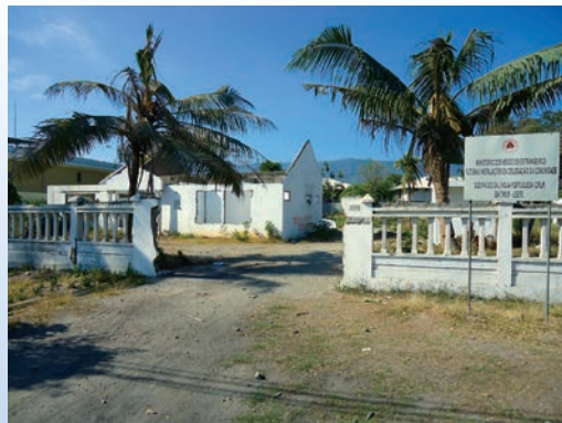
写真6 ディリ市内の破壊されたままの公共建物
