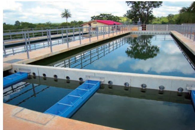
写真4 普通沈殿池
