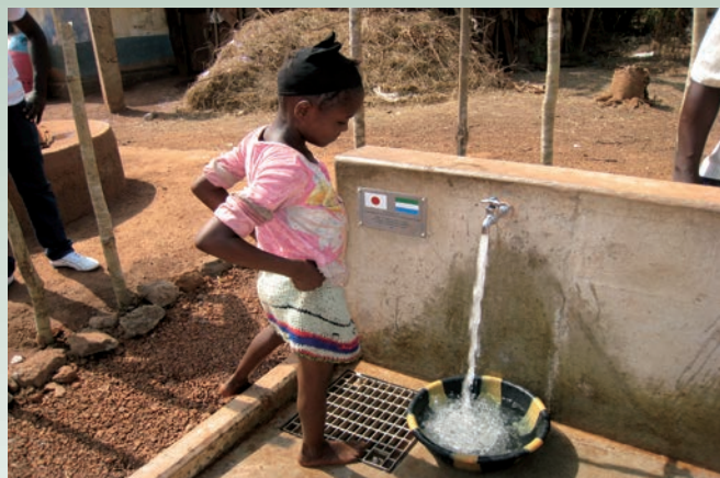
写真6 公共水栓 カンビア・タウン内に100ヶ所の公共水栓を建設した。住民は自宅から片道100m以内で水汲みができる
