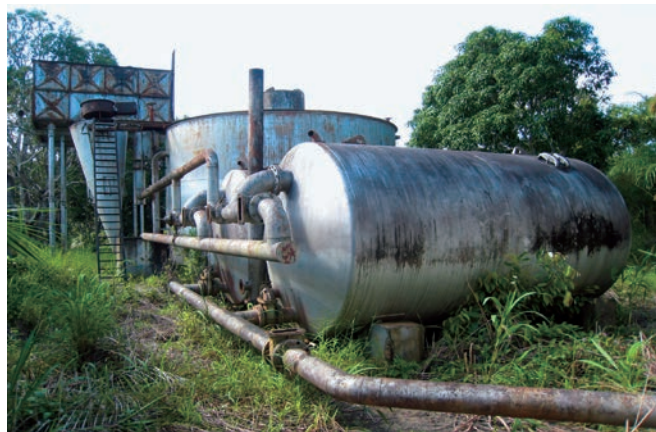
写真1 既存浄水設備
