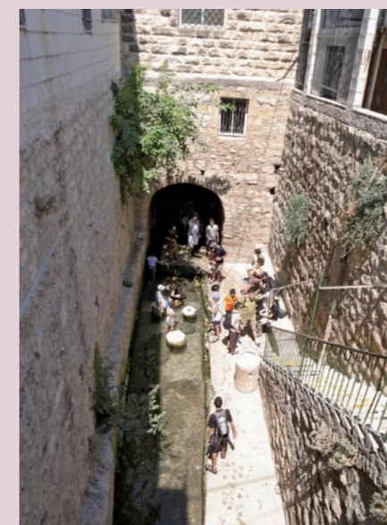
写真8 水道トンネルの出口「下の池」
