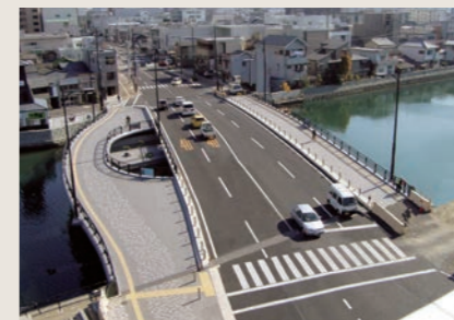
歩行者に配慮した道路と橋/福島橋
