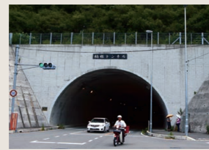
地域を結ぶトンネル/楠根トンネル
