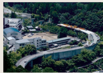
地域を結ぶ道路と橋/川井バイパス
